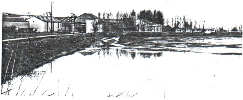
L'USINE ET UN BASSIN DE DECANTATION
